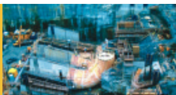
La nouvelle centrale de Grand-Mère en chantier.
